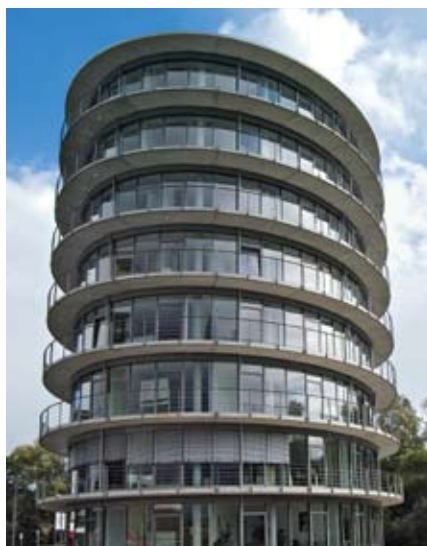
Ohne Ecken. Im 5. OG des ovalen Neubaus ist die kieferorthopädische Praxis untergebracht.
